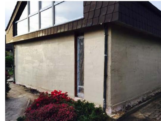
Vollflächig applizierter Hochleistungs-Dämmputz
