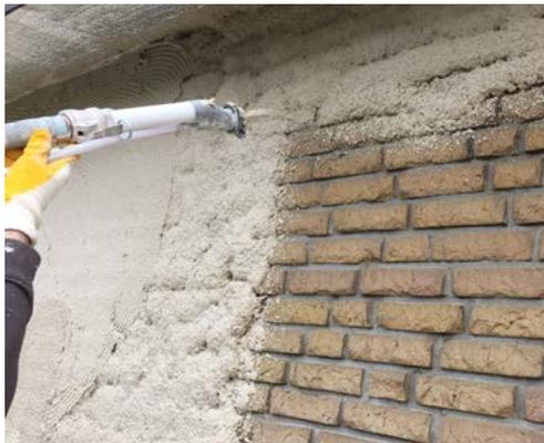
Applikation des Aerogel-Hochleistungs-Dämmputzes
